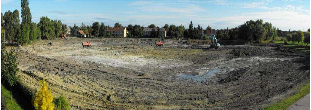
3. Kép: Tó kotrási munkálatai
